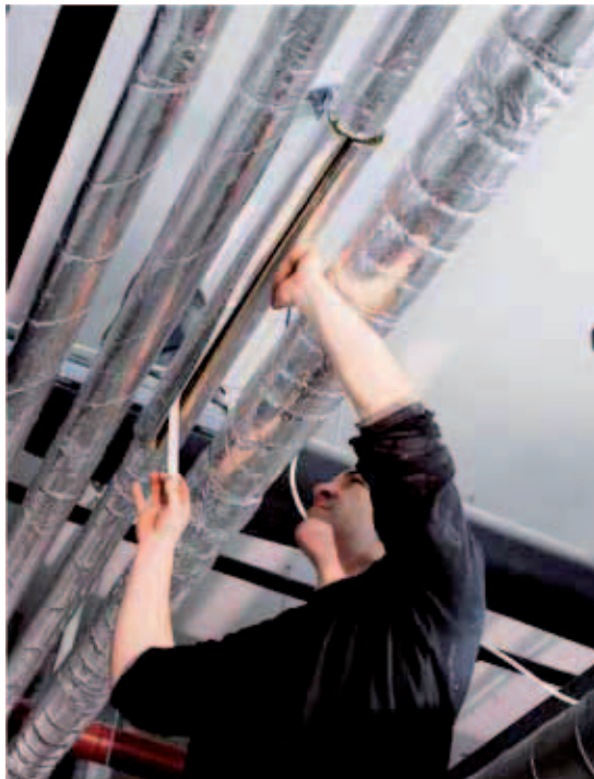
Montage der Rockwool 800 an Heizungs- und Trinkwasserleitungen
