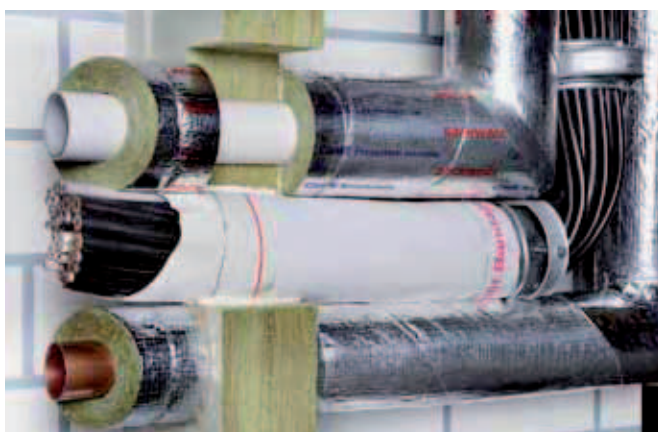
Kabelabschottungen
