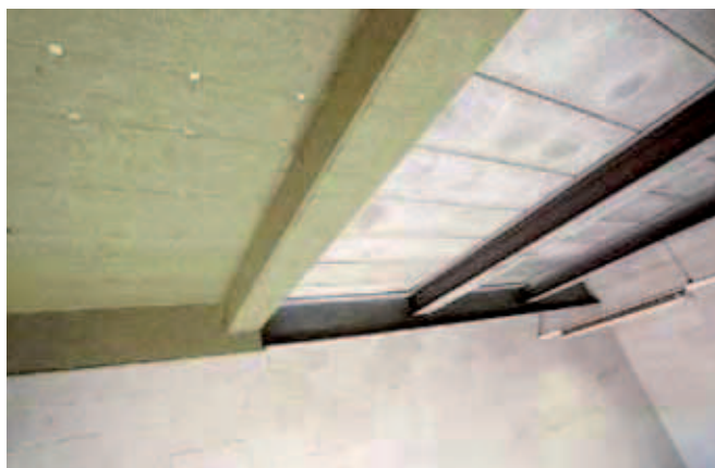
Erhöhung der Feuerwiderstandsdauer von Betondecken
