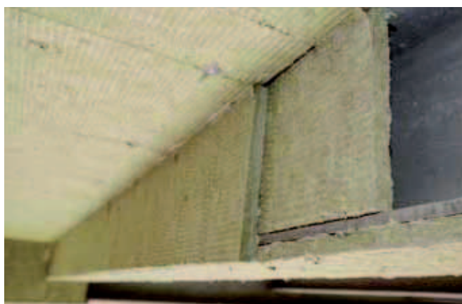
Stahlbau F30-A bis F180-A nach DIN 4102
